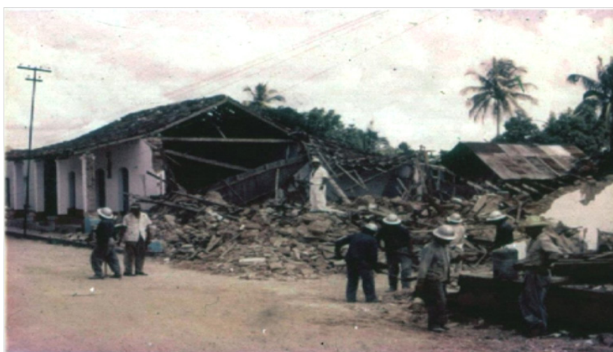
Jáltipan, Ver. “Sismo de Jáltipan”
